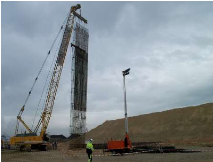
ILUSTRACIÓN 7 - INTRODUCCIÓN DE JAULA DE ARMADURA EN PANEL DE MURO PANTALLA
